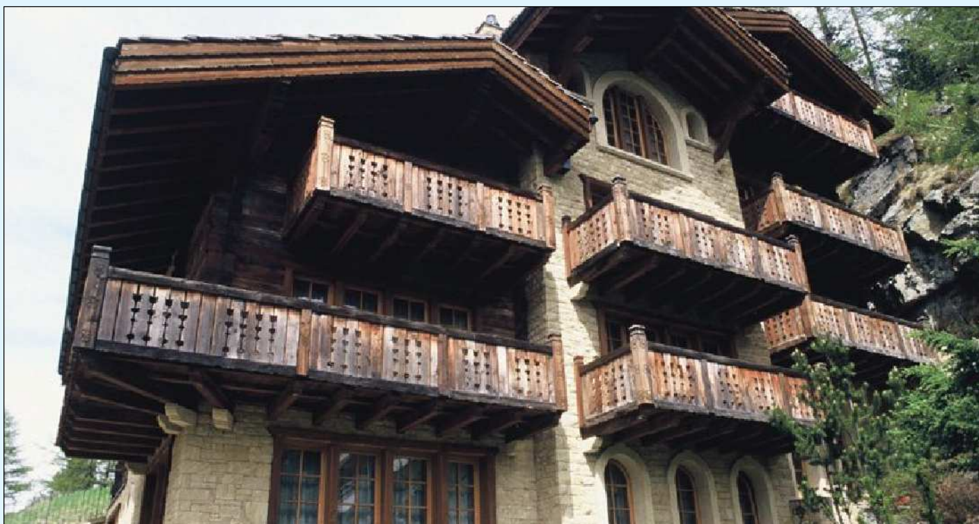
Construction d'un prestigieux chalet à Zermatt.
