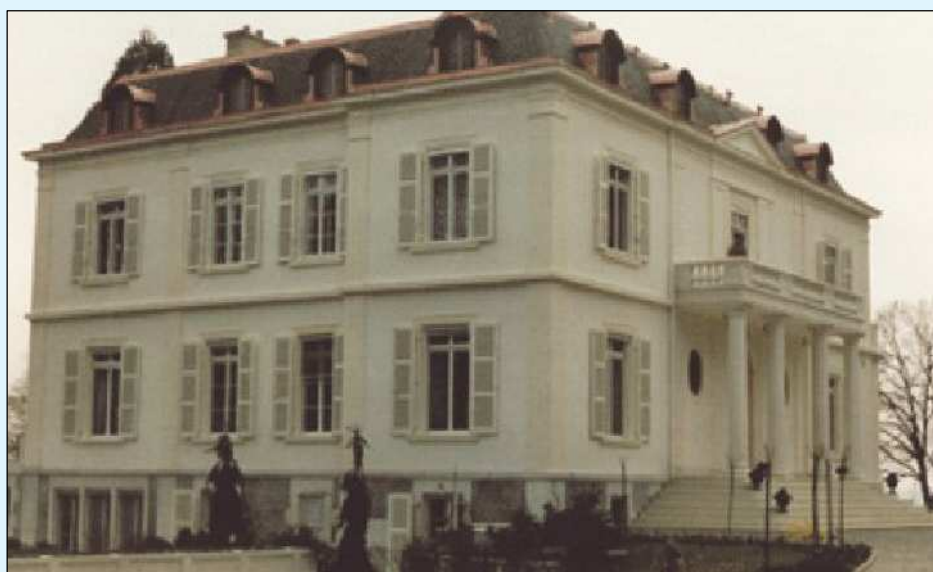
Restauration complète d'une villa au bord du lac.
